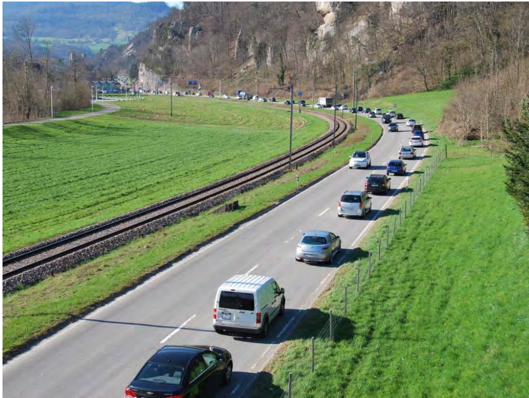
Kantonsstrasse zwischen Balsthal und Oensingen
